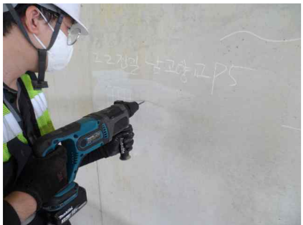
탄산화깊이 측정 현황
